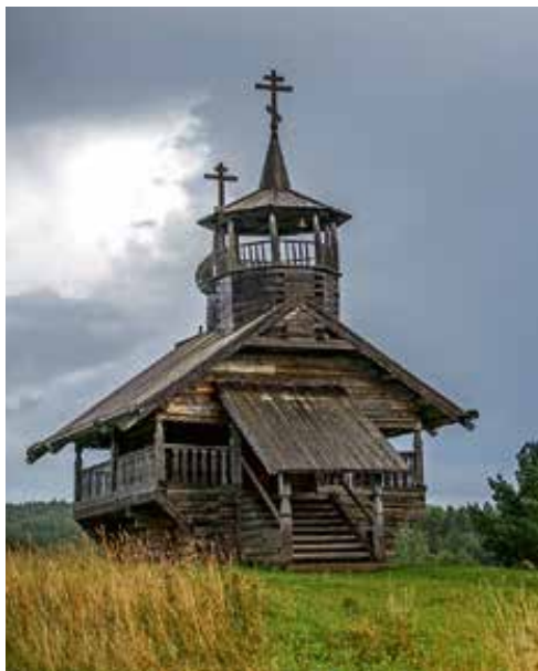
Ил. 2. Часовня Иоанна Богослова в д. Зехнова. Фото Д. Бастета. 2013 г.
