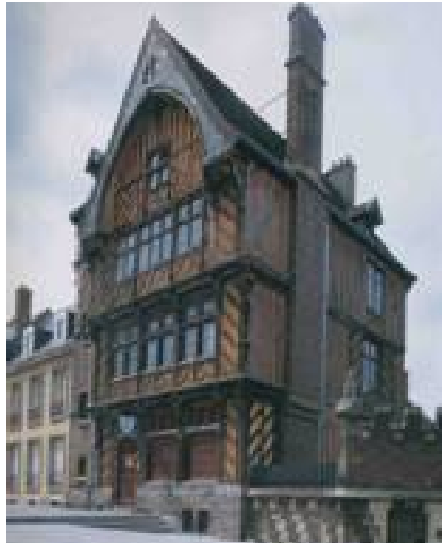
Ил. 7. Фахверковый жилой дом XV века (г. Амьен, Франция). Фото У. Прайса
