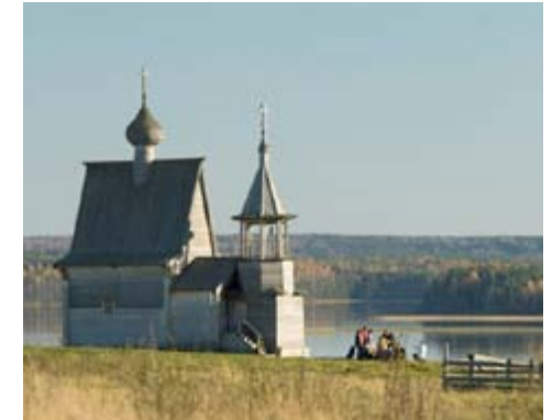
Часовня после реставрации. Фото Е. Ломакова
