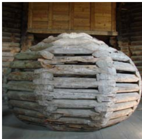
Ил. 15. Сруб первоначальной главы, хранящийся в Никольской церкви в с. Лявля (1585 г.). 2009 г. Фото И.Н. Шургина
