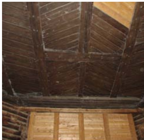
Ил. 17. Фрагмент потолка в восьмерике Никольской церкви в с. Лявля (1585 г.). Видны кронштейны, поддерживающие пристенную балку. 2009 г. Фото И.Н. Шургина
