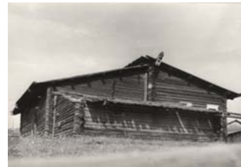
Ил. 4. Дом в д. Пожегдин (Республика Коми). Боковой фасад. Пример конструкции безвозвездового крепления кровли. 1980 г. Фото И.Н. Шургина
