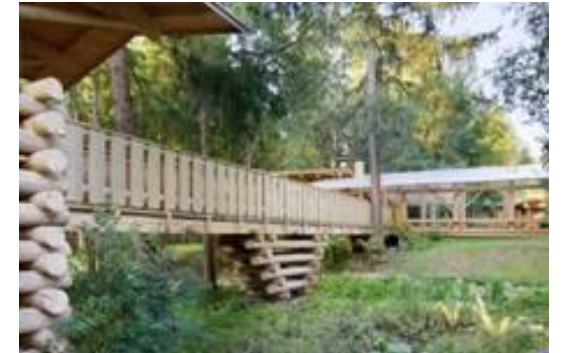
Ил. 13. Опорная конструкция перехода от бани к беседке на участке загородного дома, рубленая «в реж» (пос. Кузнецово, Московская обл.). Архитектор Н. Белоусов. 2005 г.
