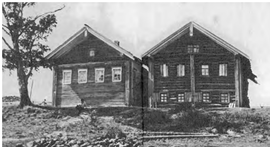
Ил. 27. Передний фасад дома с параллельной связью жилой части в д. Нямяте (Гунн Г.П. Каргопольский озерный край. М., 1984. С. 108–109)
