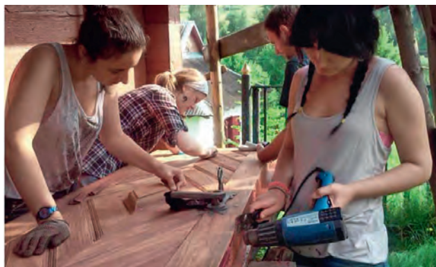
Ил. 3. Ход реставрационных работ
